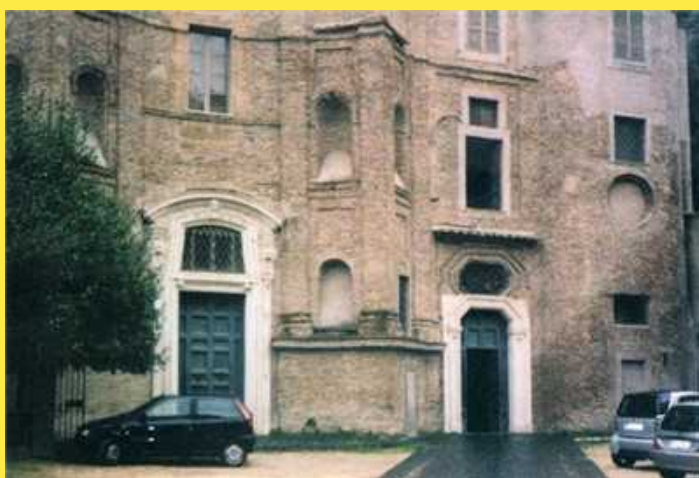
Facciata della chiesa del convento delle suore Oblate Agostiniane
