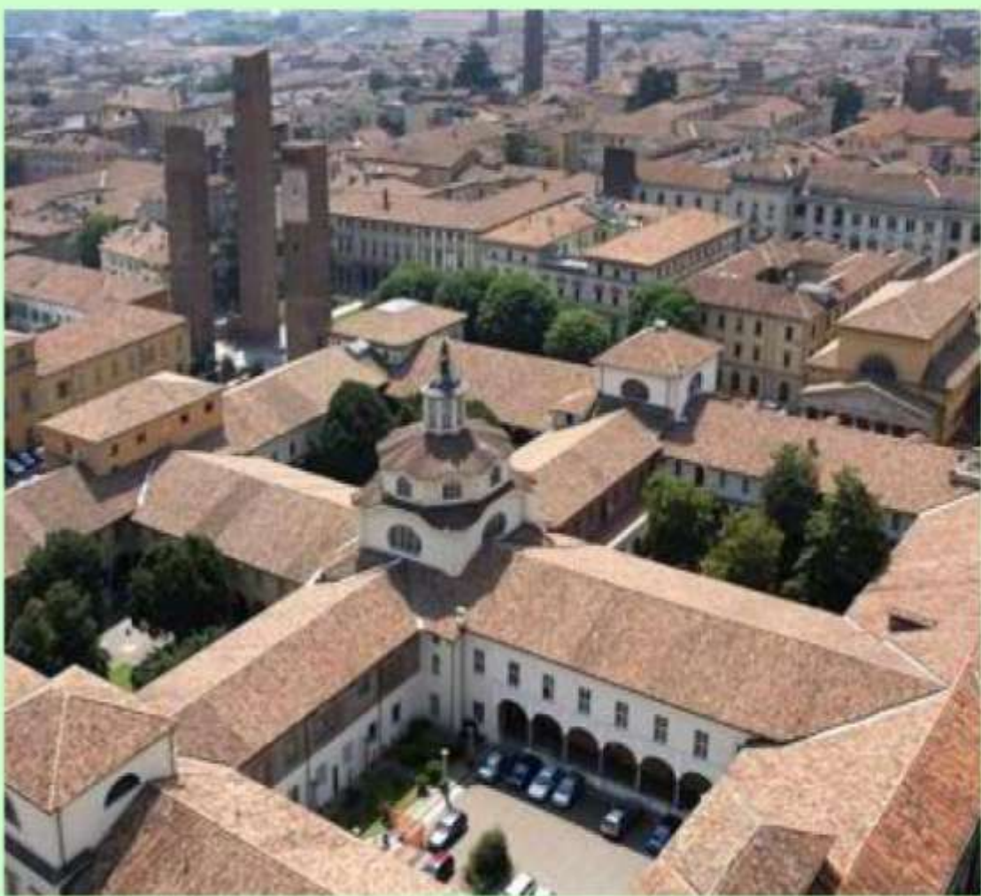
Pavia. Il complesso dell'Università
