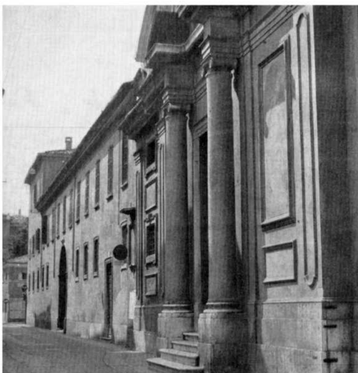
Sotto, l'attuale facciata dell'Istituto Buon Pastore in via dei Musei, già sede delle Convertite e delle Orfanelle.
