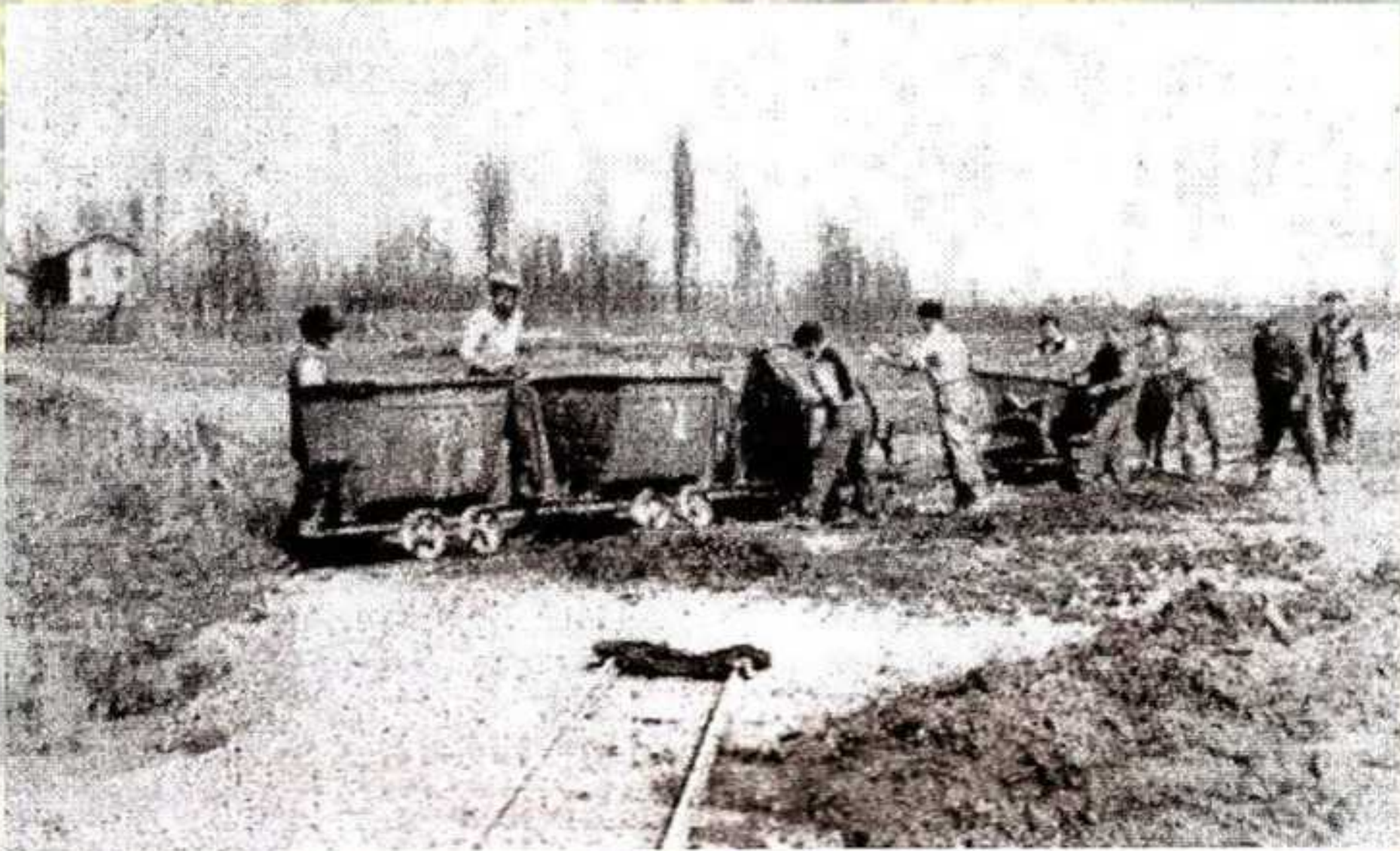
Ingenti lavori di bonifica nella bassa bresciana orientale
