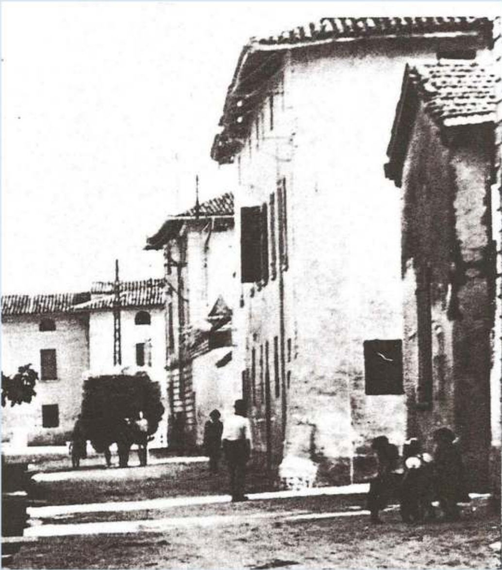
Via Marconi negli anni '50 (in corrispondenza dei bambini l'edificio con l'essiccatore di don Bonsignori)
