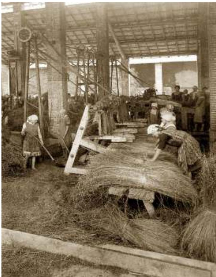
*Donne che battono il lino con una battitrice meccanica presso il Linificio e canapificio nazionale di Ponteviso*
