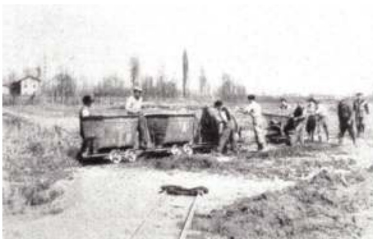
Ingenti lavori di bonifica nella bassa bresciana orientale
