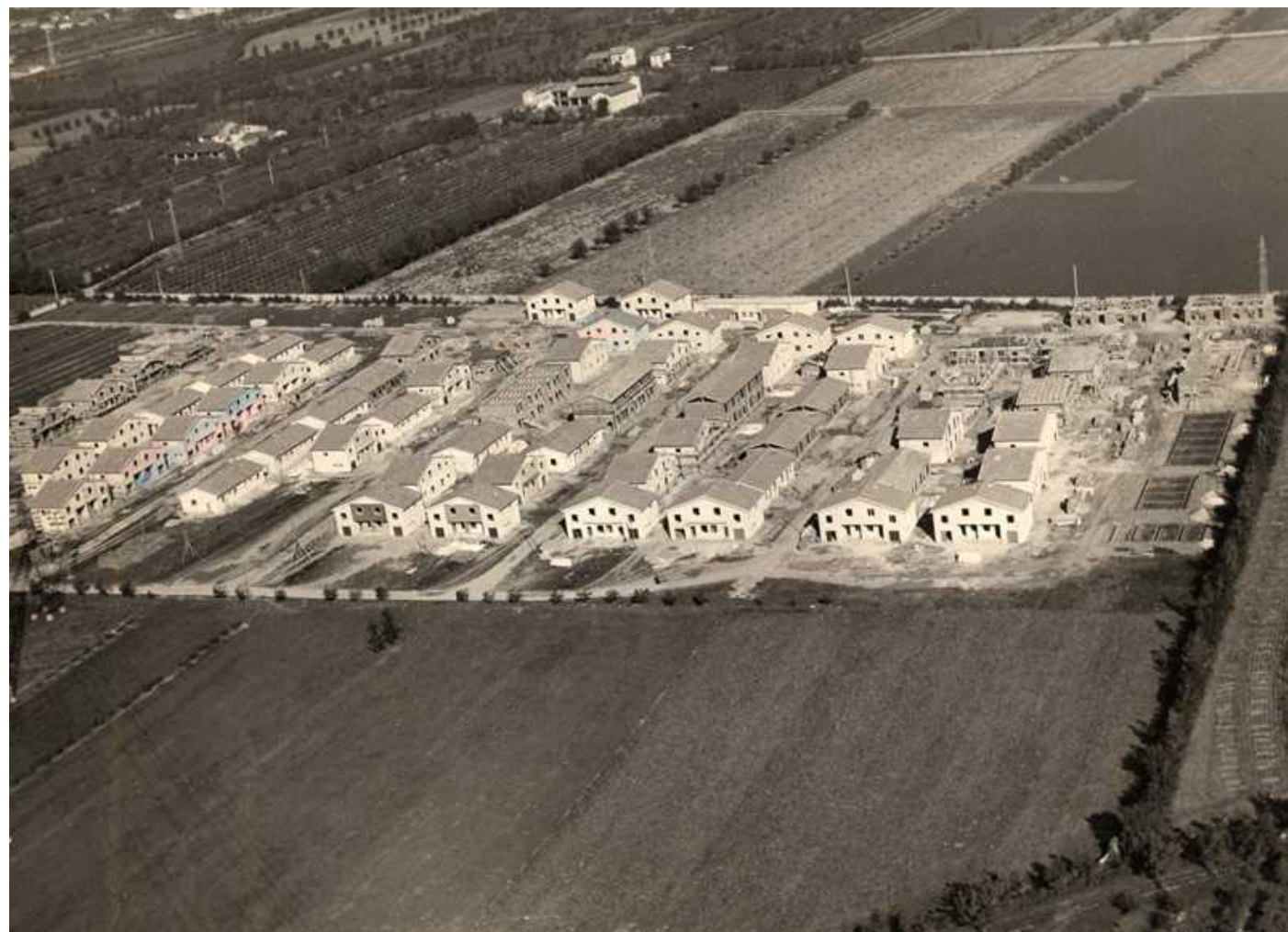
Foto aerea della zona, 1959-60
