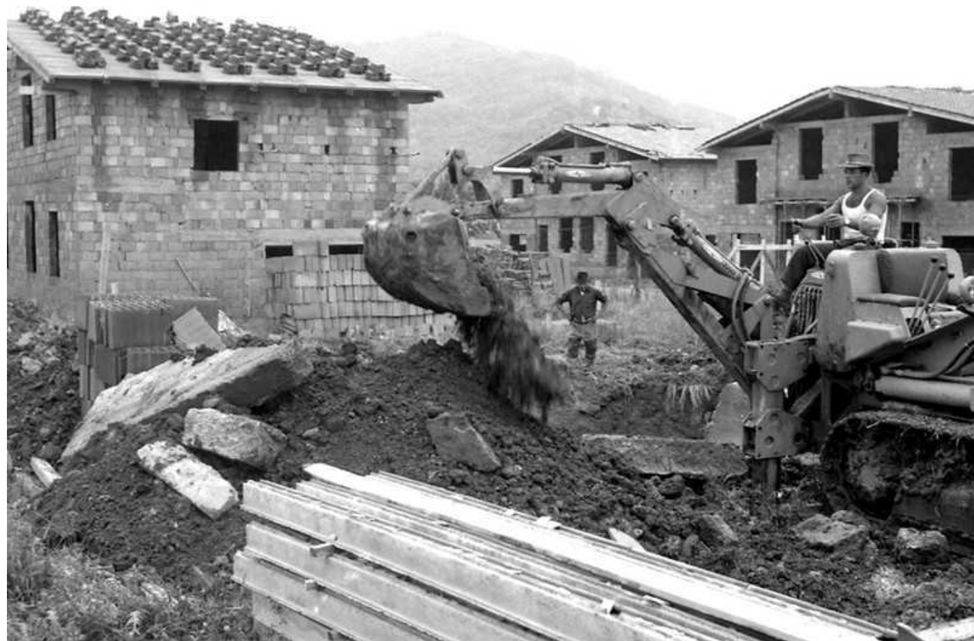
Battista, che si intravede dietro il braccio dello scavatore, arrivato tra i primi con la sua famiglia, ormai in pensione, diventa un “osservatore curioso” dell’attività del cantiere. Con la sua esperienza, tra le altre, di operaio edile, spesso darà una mano e fungerà da sorvegliante e custode.
