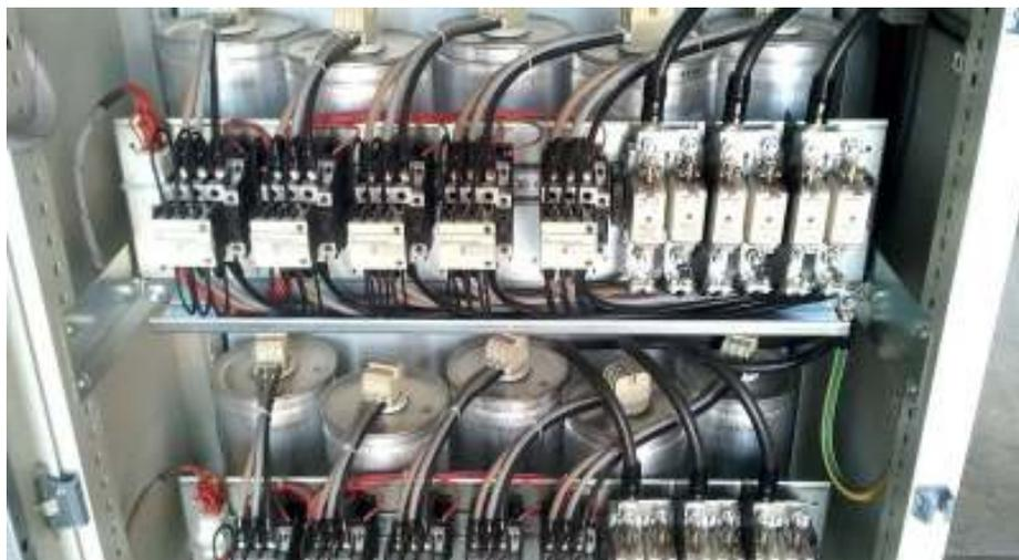
*Batteria di condensatori di un quadro di distribuzione a 380 V*
